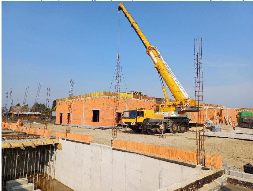
Zdjęcie 40. Budowa Centralnej Stacji Wodociągowej i budynku warsztatowo – magazynowego
