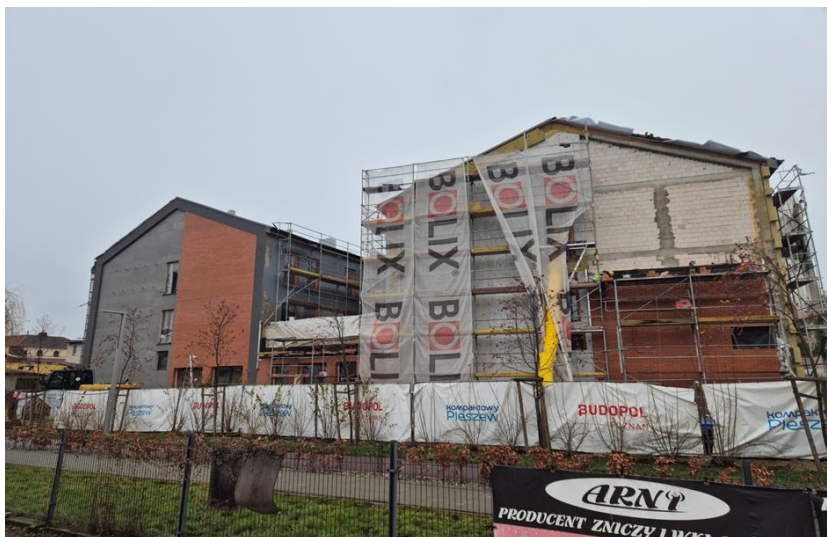
Zdjęcie 41. Compact Lab Pleszew – etap budowy 2024
